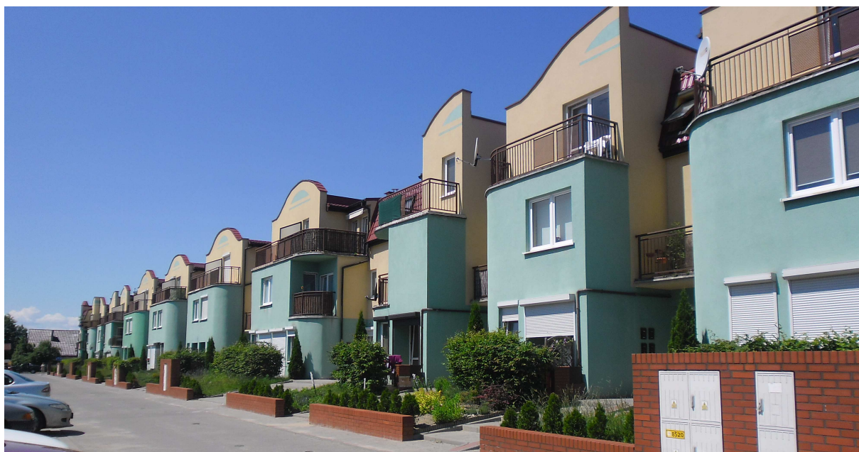
Załącznik nr 1- zdjęcia budynku przy ul. Żmigrodzkiej 11-13 w Poznaniu
