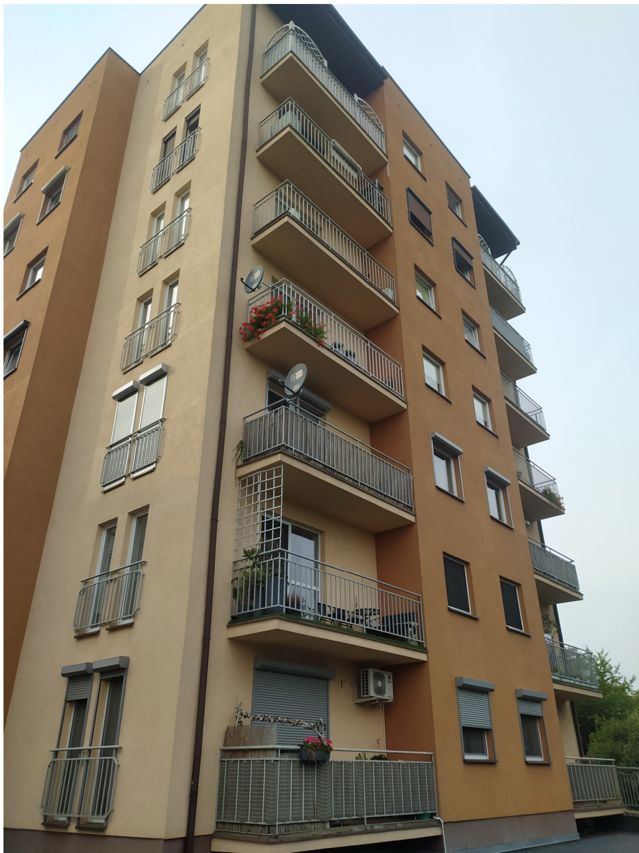
FOT. nr 2 – Widok balkonów od strony elewacji wschodniej (tylnej).
