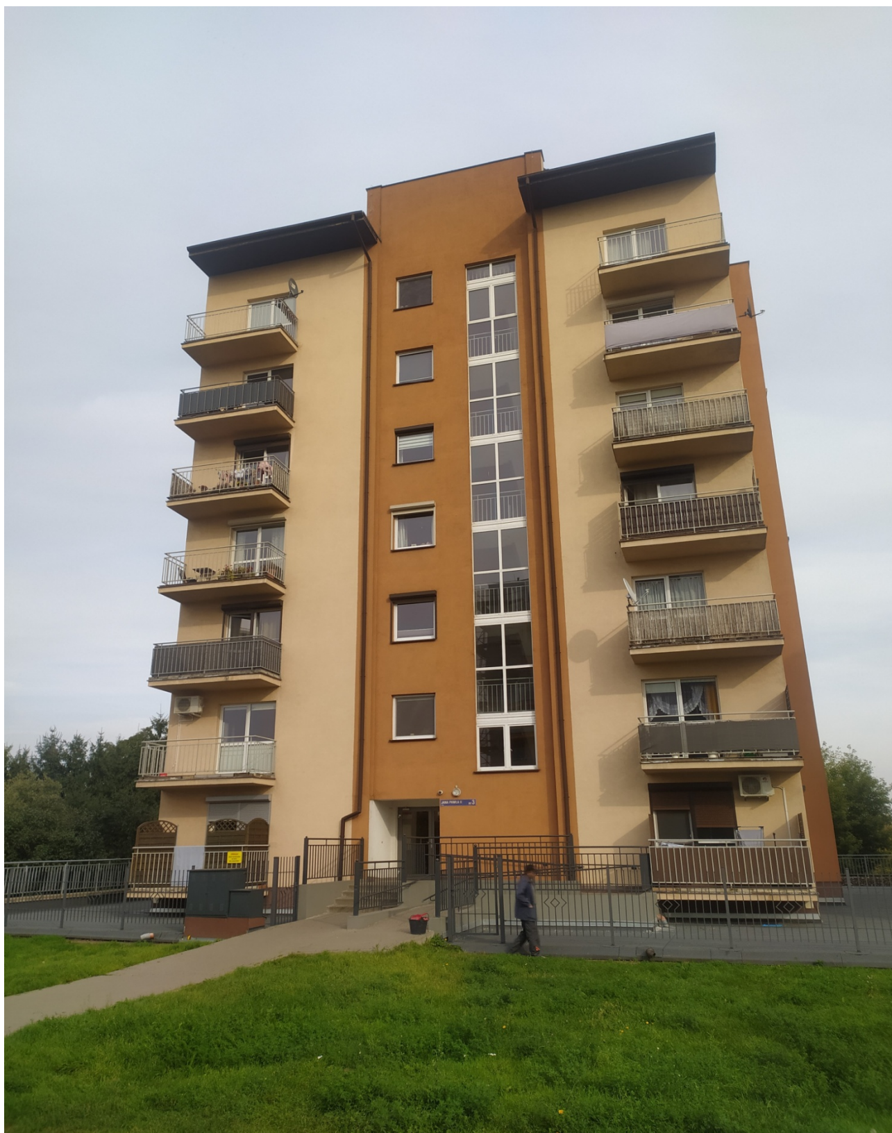
FOT. nr 1 – Widok balkonów od strony elewacji zachodniej (frontowej).
