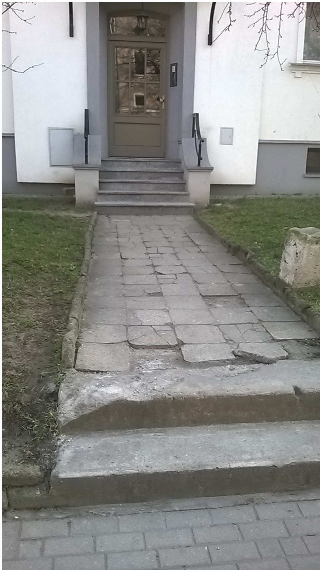
Fot. 2 Dojście do klatki nr 8
