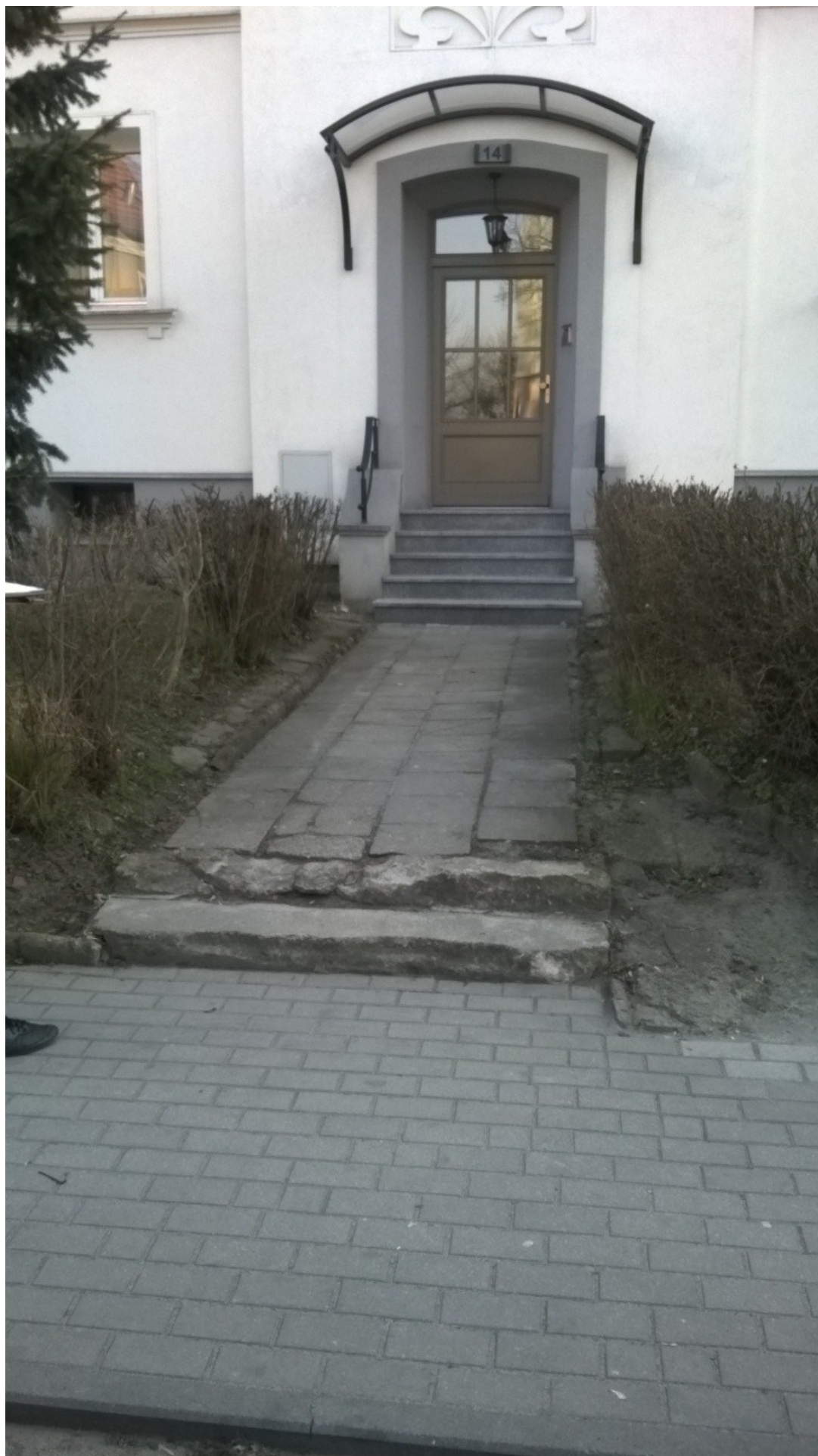
Fot. 5 Dojście do klatki nr 14
