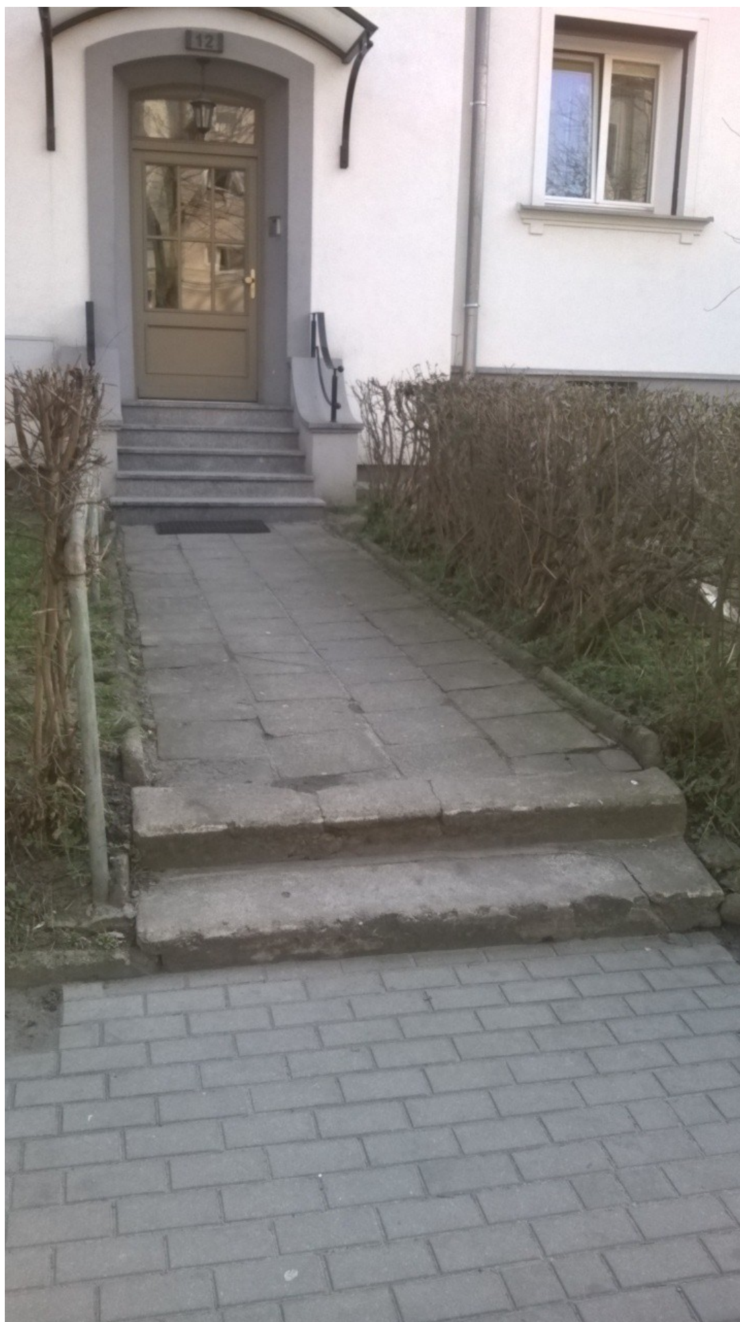
Fot. 4 Dojście do klatki nr 12
