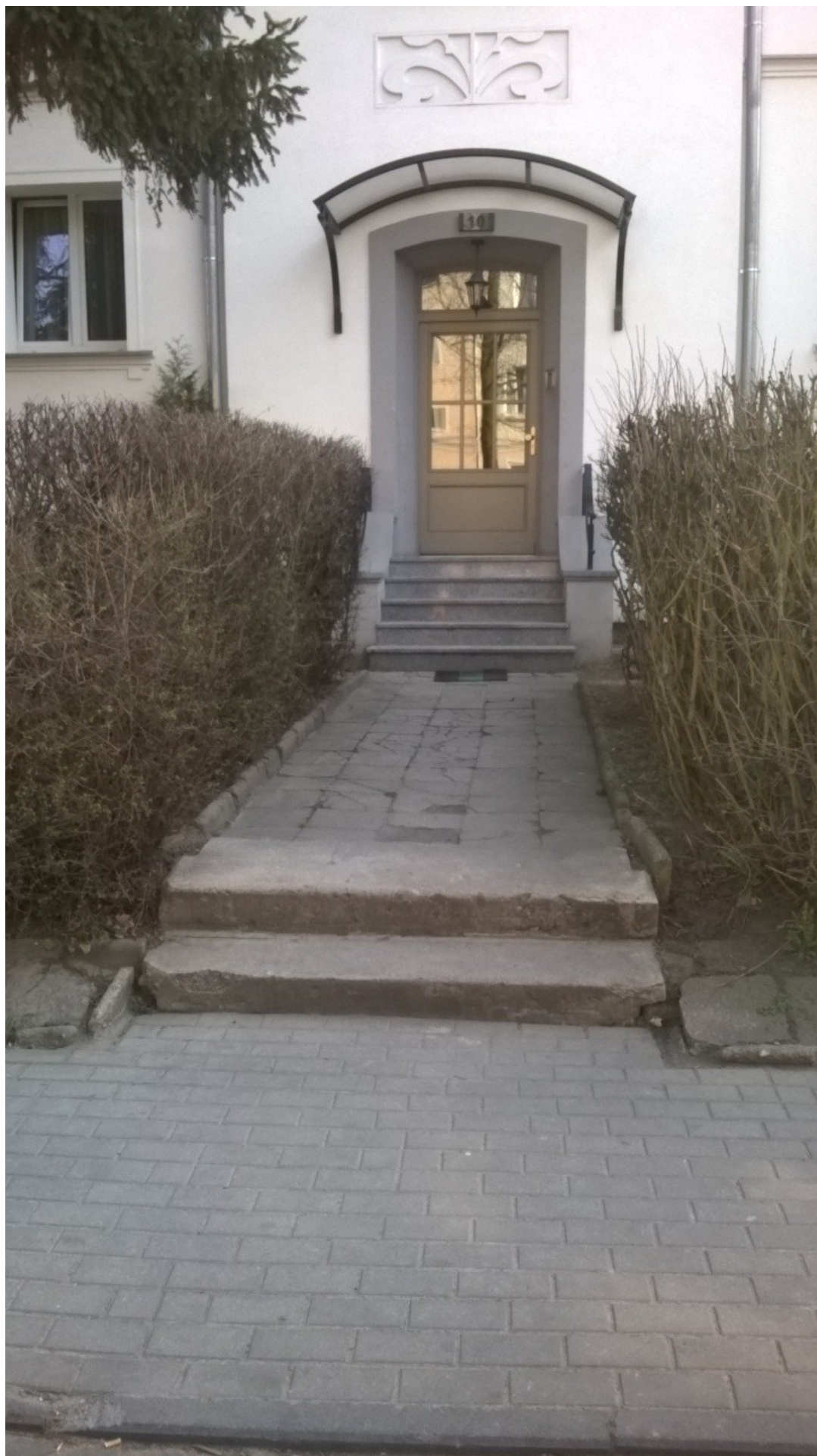
Fot. 3 Dojście do klatki nr 10
