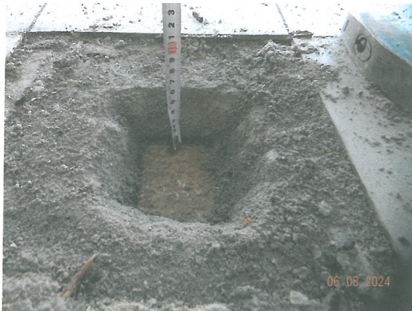
Fot. 3 – przekrój przez warstwy płyty balkonowej
