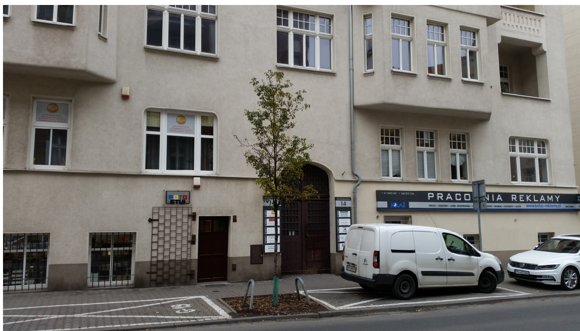
Fot.1. Elewacja frontowa - wejściowa
