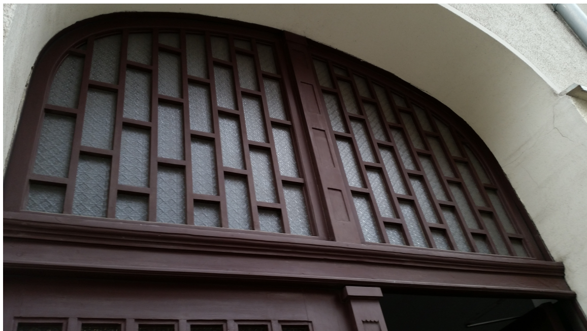
Fot.3 Widok na świetlik od strony wejścia
